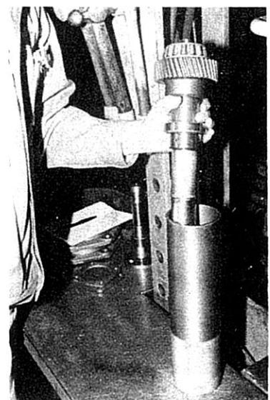
40. 出力軸半仕組を治具 j に取り付ける。
